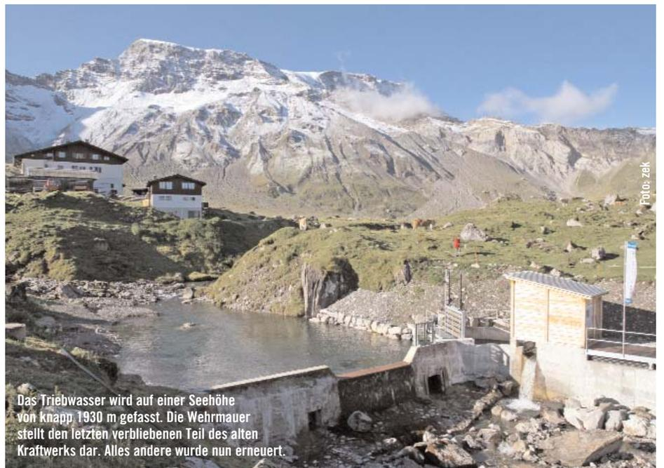
Das Triebwasser wird auf einer Seehöhe von knapp 1930 m gefasst. Die Wehrmauer stellt den letzten verbliebenen Teil des alten Kraftwerks dar. Alles andere wurde nun erneuert.
